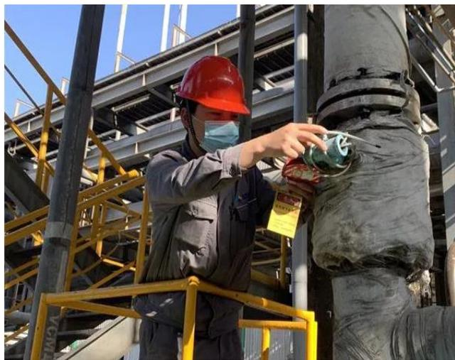
安全员现场检查上锁挂牵（朱宏娟摄）。聚合车间工艺副主任工汤坤尧说，车间严格按照一证、一单、一图、一表（管线打开许可证、JSA、盲板图及确认卡、隔离清单）全面推进，并由安全组每天在生产协调会上对各项作业推进情况进行汇报。目前，聚合车间各工序已全面实行管线打开作业管理，车间也将根据实际运行情况，不断完善、优化、推进管线打开作业管理逐步流程化、规范化、固定化，为车间安全生产提供有效保障。
