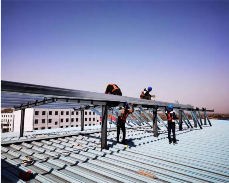
为了达到室内通风降温，确保正常生产和员工安全，从4月7日开始，电化分公司决定在电石冷却车间现有顶棚的屋脊部位加装敞开式通风天窗。
