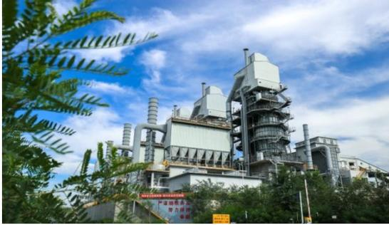
公司牢固树立“全员营销、全员创业、全员节约”意识，坚持全员行动、挖潜增效，近年来，先后完成气力输灰系统改造，实现烘干灰 100%掺烧利用；开展脱硫磁悬浮风机
