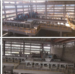
中石化长城能源化工（宁夏）有限公司 自动化电石卸料站6套
