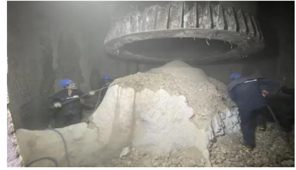
▲外协施工人员清理窑内结瘤
